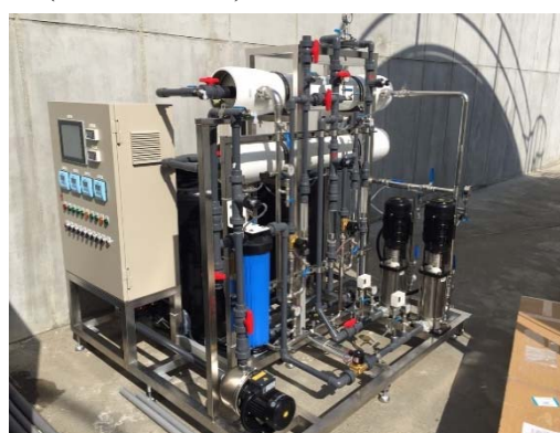
圖 5.某工業區某石化廠之水回收處理系統 Pilot 模型廠(RO)
